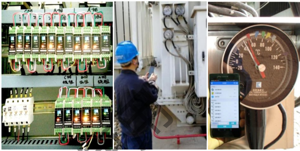
图 5 现场不停电巡视校准图
